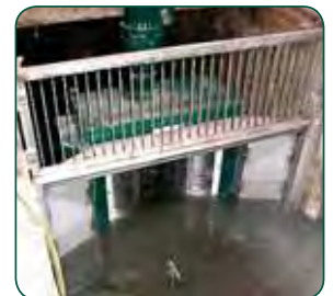
Châssis en acier inoxydable avec barreaux de dégrillage en cas de crue
