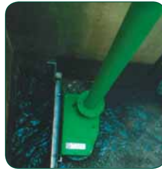
Channel Monster avec extension d'arbre.
