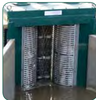
Modèle CDD6020-XDM2,5 installé en entrée de station.
