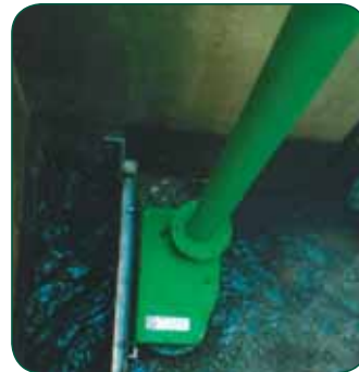
Channel Monster model CMD z wydłużonym wałem.
