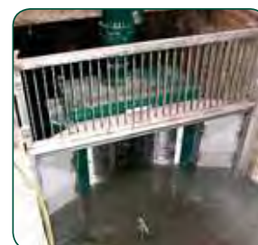
Rama ze stali nierdzewnej z kratą przelewową
