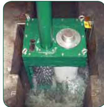
Ten CMD zastąpił starą kratę ręczną bez potrzeby przebudowy kanału.
