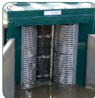
Modell CDD6020-XDM2,5 före fingaller på ett reningsverk.
