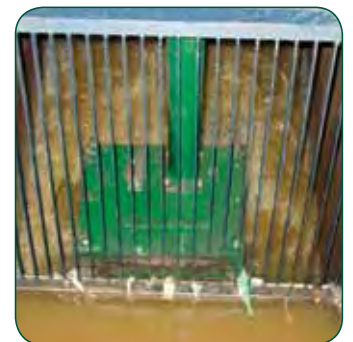
Channel Monster med bräddavloppsgaller.
