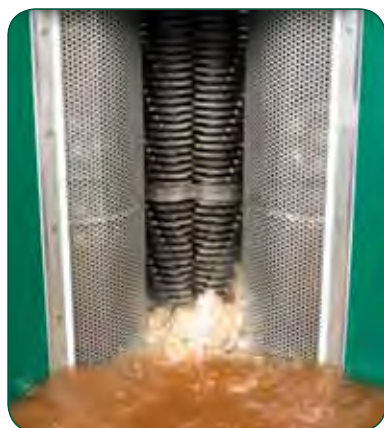
Avloppsvatten vid inloppet till en Channel Monster- kvarn.
