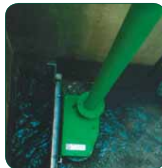
Channel Monster med förlängd motoraxel.
