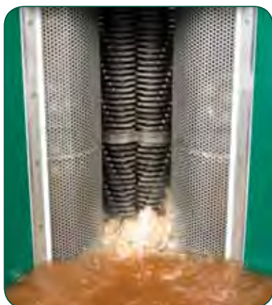
Abwasser fließt in einen Channel Monster Zerkleinerer ein
