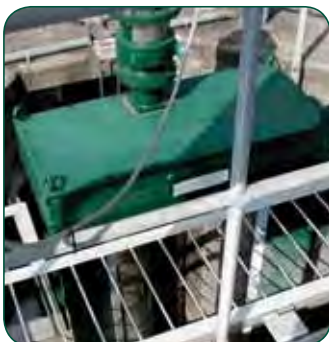
Channel Monster Modell CDD im Abwasserzulauf.
