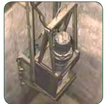
Installation des Channel Monster in Pumpstation mit Führungsrahmen.
