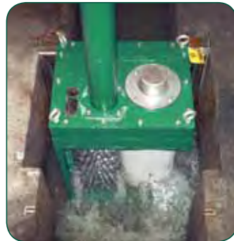
Modell CMD hat einen alten Rechengutzerkleinerer ersetzt.
