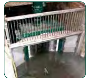
Asennuskehikot ja ylivuotoseula ruostumattomasta teräksestä
